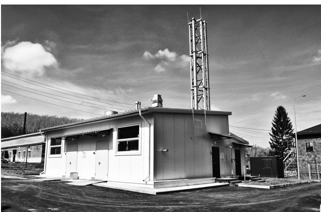
Новая газовая котельная в селе Алтайское.
