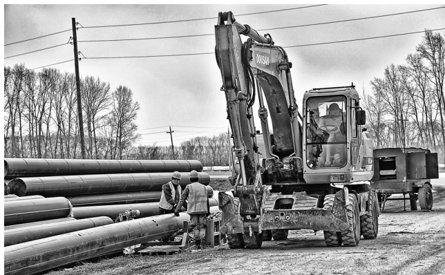
Замена водопроводных сетей на аварийных участках Чарышского группового водопровода.
