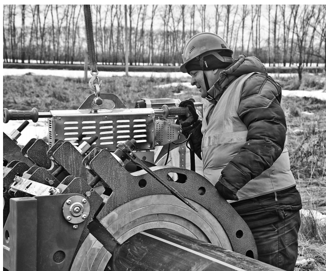
Ремонт водопровода в Шипуновском районе.
