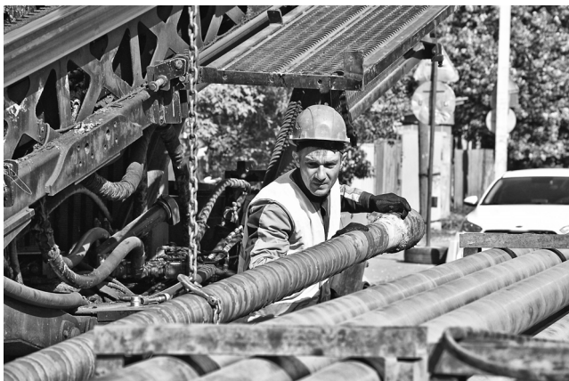
Ремонт коллектора в Новоалтайске.
