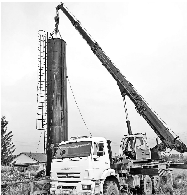
Замена водонапорной башни в с.Верх-Камышенка, 2024г.
