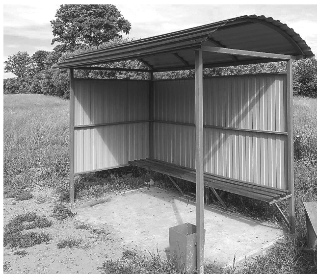
Проекты «Ремонт дороги» в с.Верх-Суетка муниципального округа Суетский район и «Обустройство автобусной остановки» в с.Таловка Первомайского района (2024г.).
