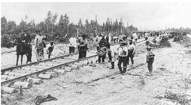
Строительство железной дороги.
