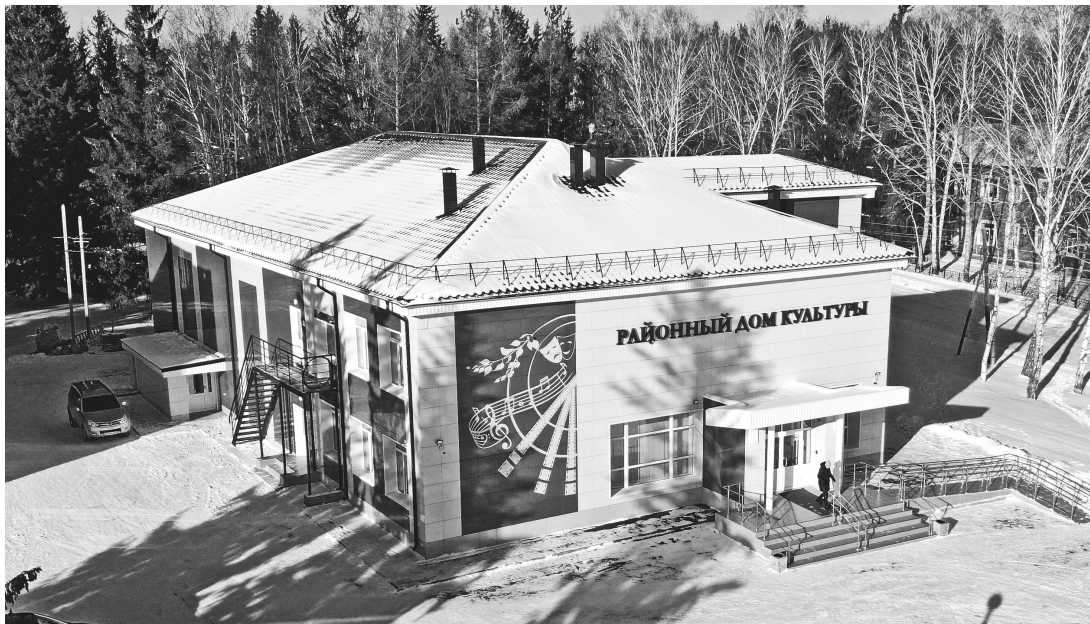
Косихинский районный Дом культуры после капитального ремонта (объект 2022г.).
