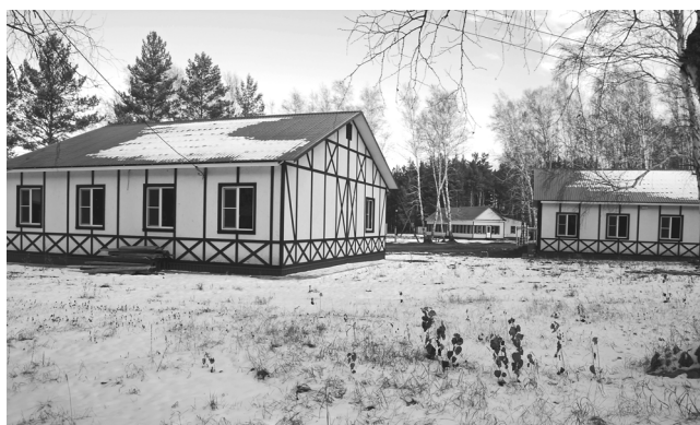
Строительство спального корпуса в ДОЛ «Орлёнок» в Панкрушихинском районе (2024г.).
