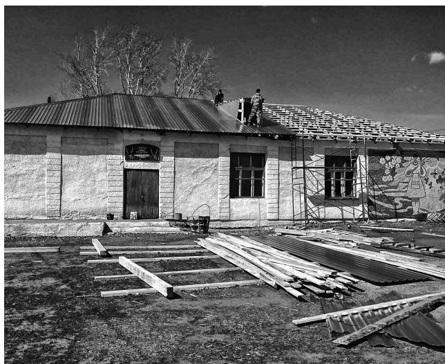
Ремонт Дома культуры в с.Зыково.
