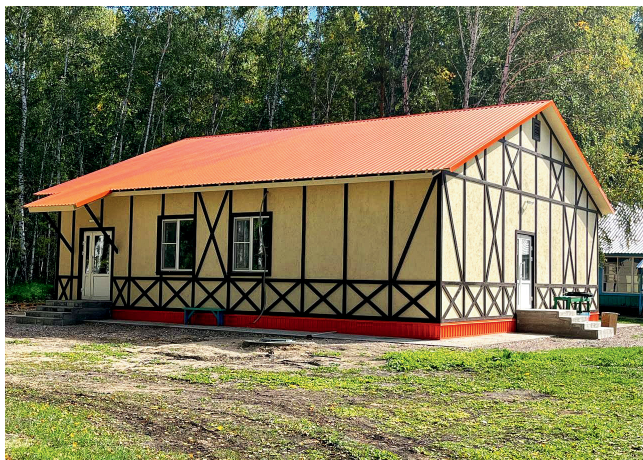
В 2023 году по ППМИ построен новый спальный корпус на 24 места в детском оздоровительном лагере «Орлёнок».
