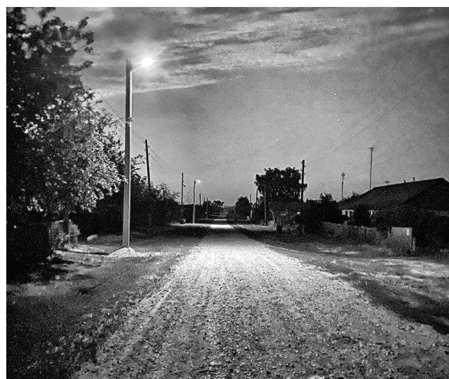
В с.Урываево смонтировано уличное освещение.
